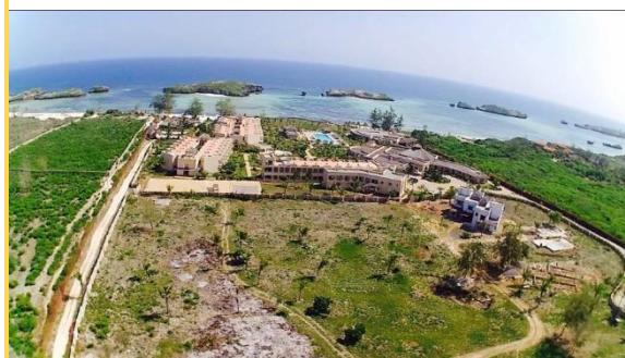
Qui sopra una fotografia aerea del plot all'inizio dei lavori di costruzione
